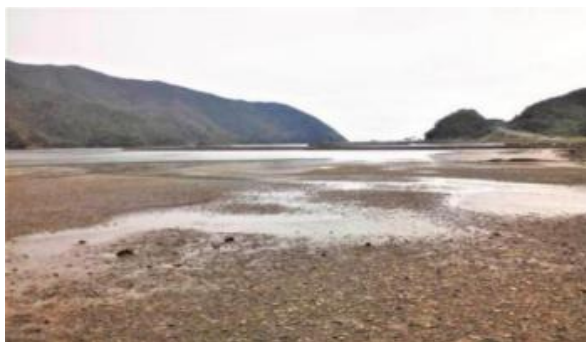
導流堤により河口に溜まり続ける土砂 ③
