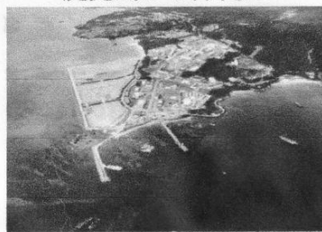
辺野古の工事現場(琉球新報より)
