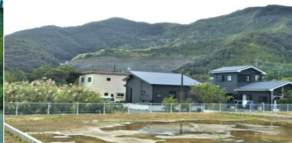
採掘現場は住宅のすぐ裏 ⑩
