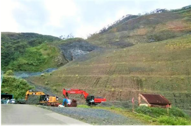
本土資本の業者による碎石場 ⑦
